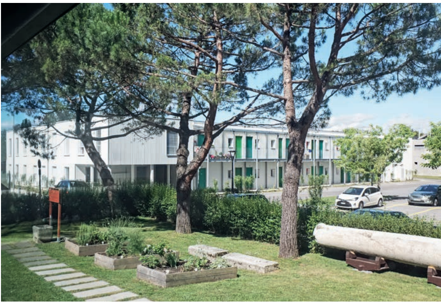
Schnell gebauter und günstiger Wohnraum in Lausanne. Initianten waren zwei junge Architekten.
